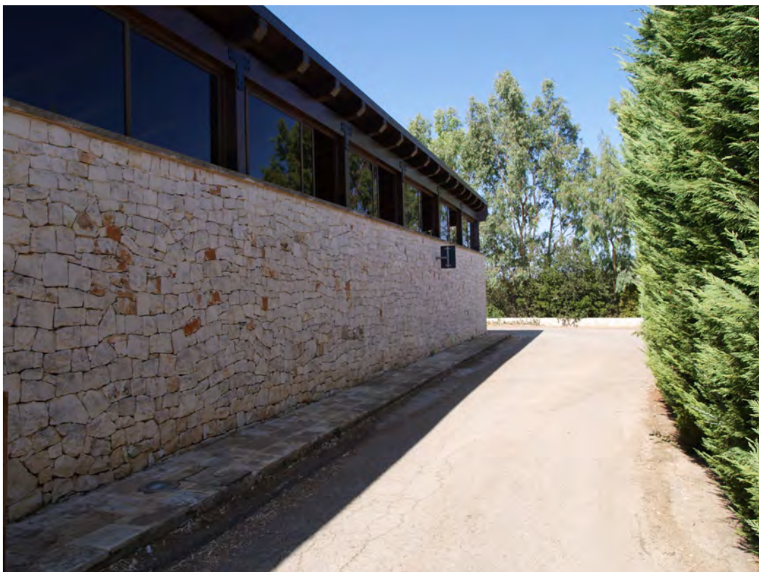
Foto 27 – Fronte esterno della "Corte" con viabilità di servizio per accesso alle strutture logistiche
