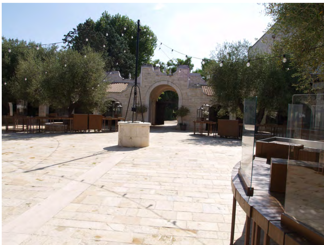
Foto 22 – Ingresso principale alla "Corte" dall'interno
