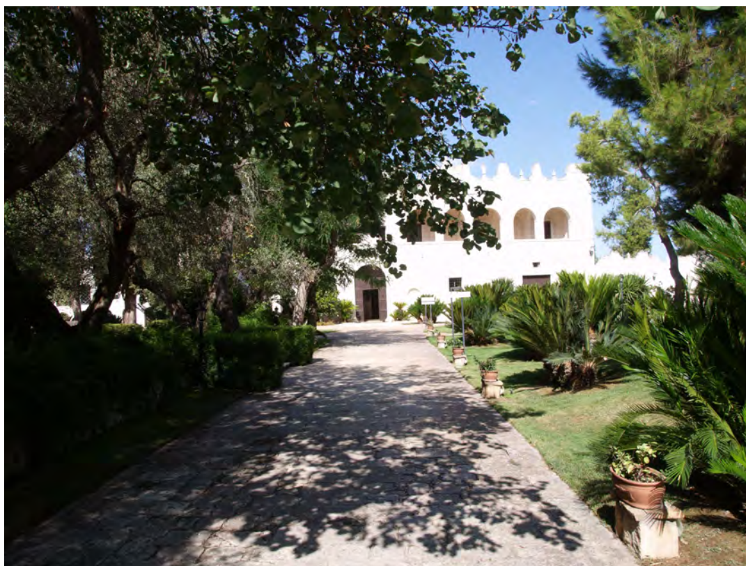
Foto 8 – Viale di ingresso principale e scorcio di "Villa Menelao"
