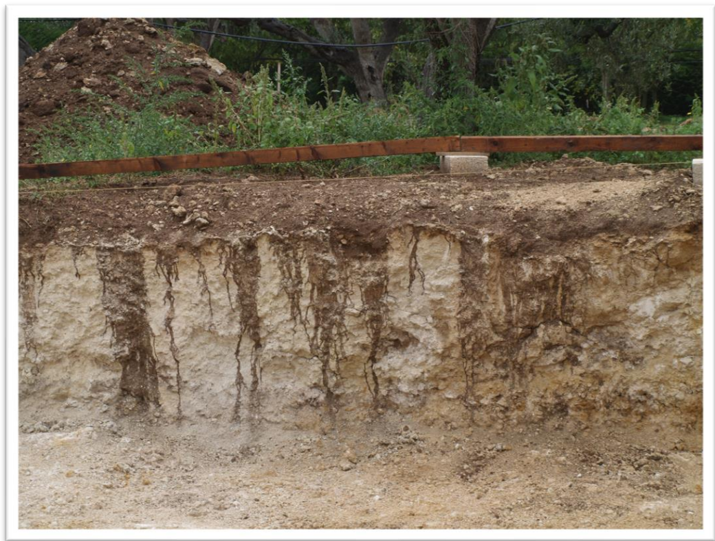
Foto 1 – Scavo in roccia calcarenitica nel sito d'interesse.
