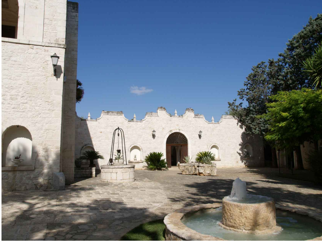
Foto 5 _ Prospetto di ingresso "La Corte" vista dall'esterno
